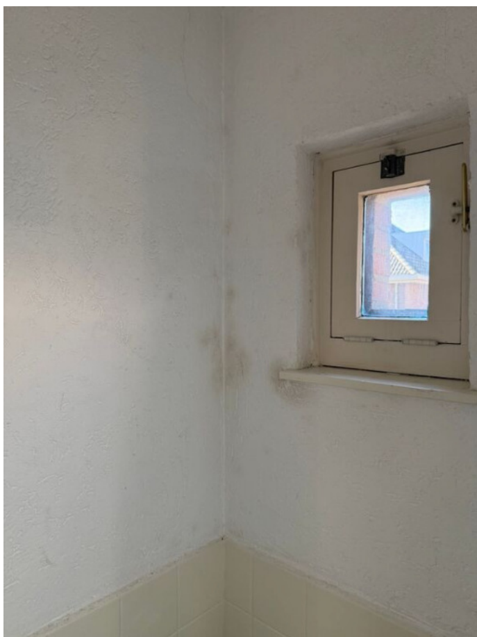
Enkel glas toilet
