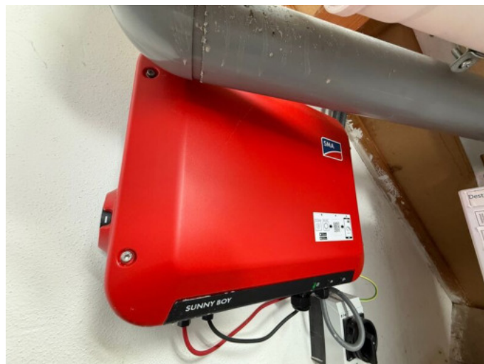
Omvormer zonnepanelen
