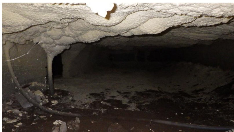
Foto 05: Kruipruimte; De onderzijde van de vloer is voorzien van na-isolatie.
