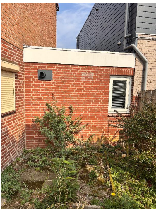
Foto 09: Rechtergevel; In de gevel van de belendende bebouwing is een (te openen) gevelkozijn gesitueerd op de perceelsgrens.
