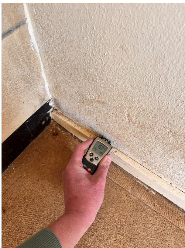
Foto 04: Woonkamer; Op diverse locaties is optrekkend vocht geconstateerd in de wanden.
